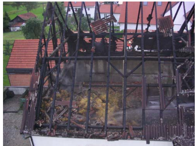
Auf der Hinterseite ist der Neubau der Garagen des Nachbargrundstückes zu sehen.
