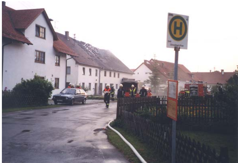
Nordansicht des gesamten Objektes
